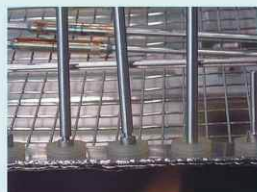
Napojení konektorů
