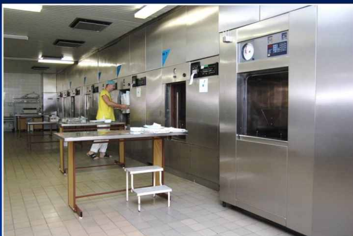
Před rekonstrukcí – sterilizace
